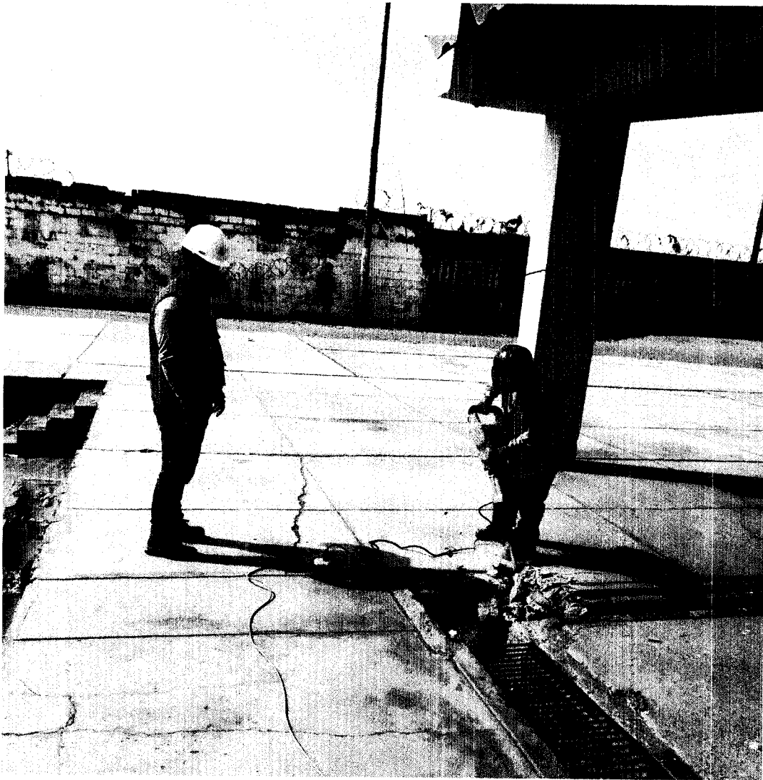
DEMOLICION DE CANALETAS
