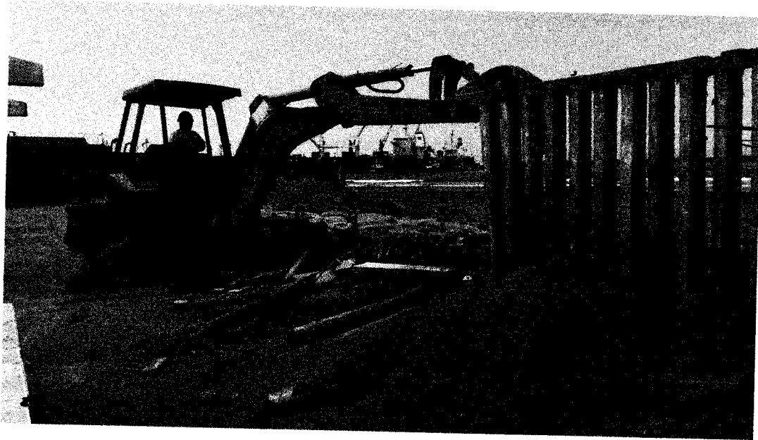
Foto N° 09 Tareas de demolición de cerco de columnas de concreto.
