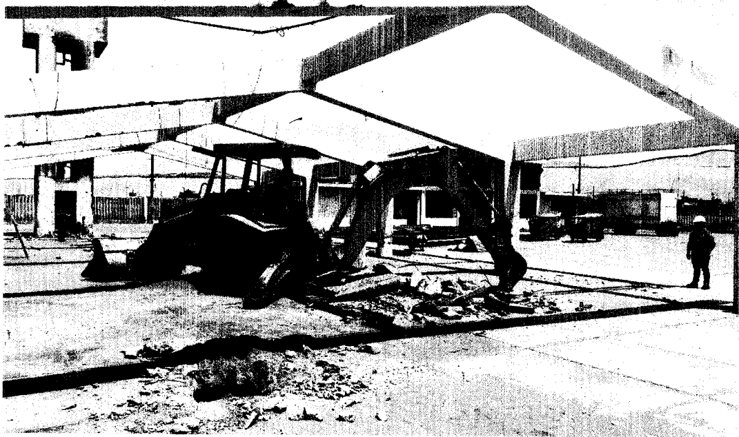
DEMOLICION DE TINAS EXISTENTES
